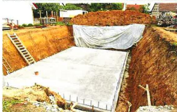
Baugrubensicherung durch Pfahlwände (oben) sowie – oft bei Einfamilienhäusern – durch eine einfache Böschung (unten)
